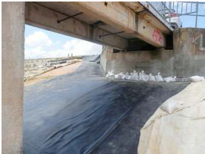
Verlegung der PVC-Dichtung am Widerlager im Juli 2021; Fotonachweis: Thüringer Fernwasserversorgung, Jochen Mehl
