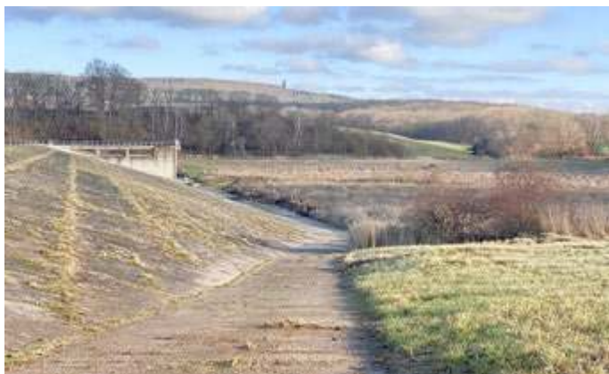
Blick auf die einzustauende Talsperre Hopfgarten; Fotonachweis: Thüringer Fernwasserversorgung, Anne Barthel
