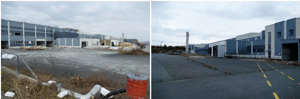
Abb. 1 & 2: Bereich des Baufeldes A mit dem ehemaligen Fleischzentrum Nohra und hohem Versiegelungsgrad
