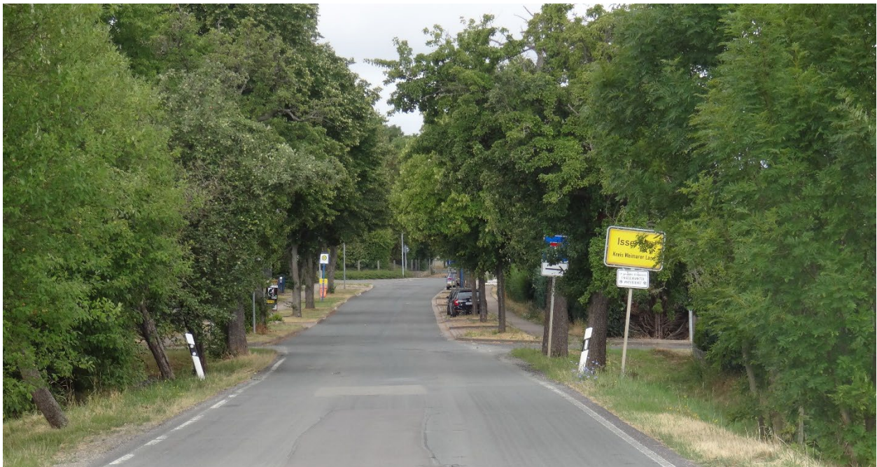
Ortseingangssituation mit Einmündung des Brunnenweges
