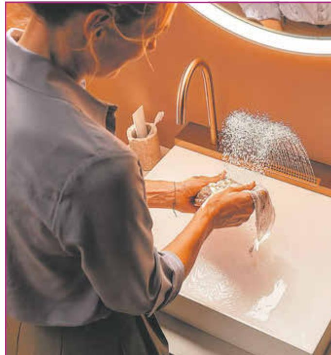
So wird auch der nachhaltige Umgang mit der kostbaren Ressource zum reinsten Wasservergnügen. Alle Bedienelemente der Avalegra AquaUnit sind in einer einzigen funktionalen Einheit zusammengefasst. Im Mittelpunkt steht die integrierte Strahlmatte. Die Griffe rechts steuern wie gewohnt Wassermenge, Strahlart und Temperatur. Der Farbkontrast zwischen Becken und Bedieneinheit ist bewusst gewählt. Das mattweiße Waschbecken aus Mineralwerkstoff ist langlebig, kratzfest und pflegeleicht.
